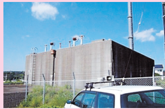
水戸西流通センター配水池 水戸西流通センター周辺に 配水しています。 有効容量:200m 3 ×2池
