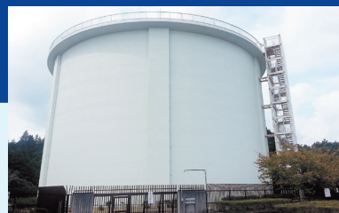
楮川第1配水池
