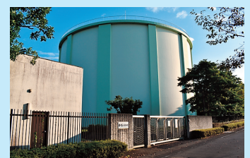
楮川第2配水池 水戸市内北部へ配水してい ます。 有効容量:12,000m 3
