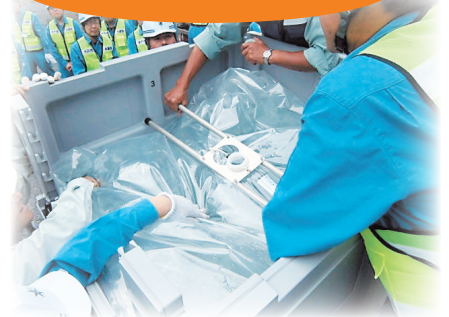
応急給水装置内部の様子
