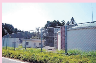
内原配水池 開江浄水場の他、茨城県中 央広域水道用水供給事業か ら水を受けて、内原地区に配 水しています。 有効容量:3,000m 3
