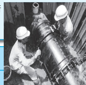
水道管の更新・耐震化の様子
