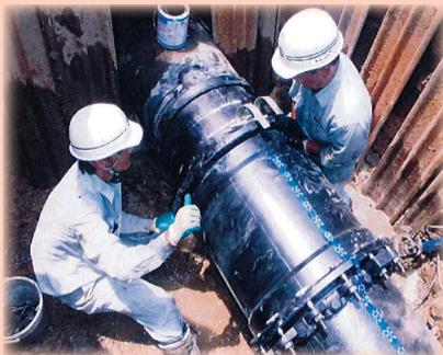
口径500mm耐震管の布設の様子
