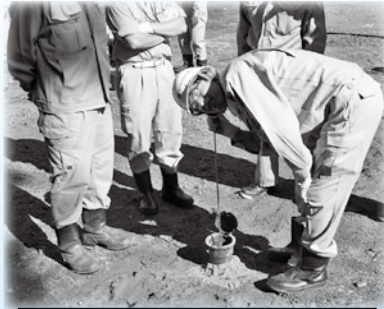
音聴棒による漏水調査
