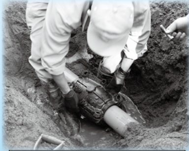
漏水修理状況
