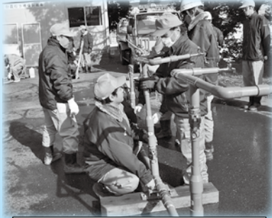
仮設給水所の設置
