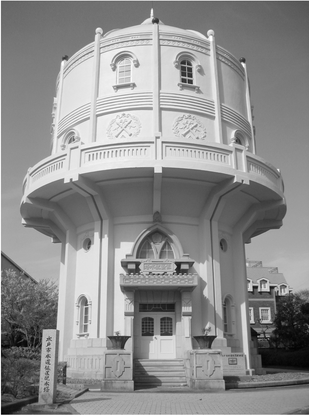
【低区配水塔】 平成8年12月6日 登録有形文化財指定
