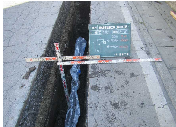
No.10 (有)協栄工業 配水管布設替工事(第30工区)
