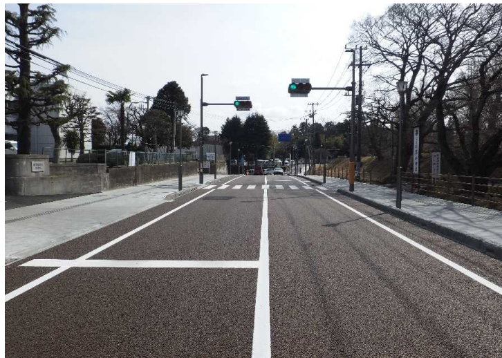
No.3 秋山・石翠園JV 都市計画道路3・4・14号道路改良・電線共同溝(5工区)及び公共下水道北見・根本排水区枝線(3-3工区)工事
