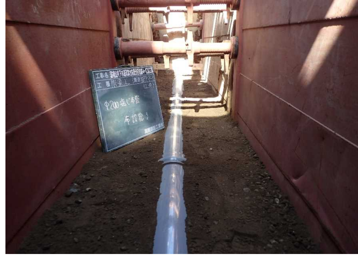
No.14 高橋建設工業(株) 国補公共下水道双葉台処理分区枝線(4-1工区)工事
