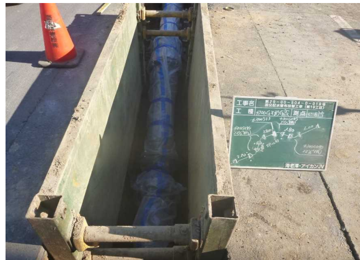
No.6 海老澤・アイコンJV 国交配水管布設替工事(第19工区)
