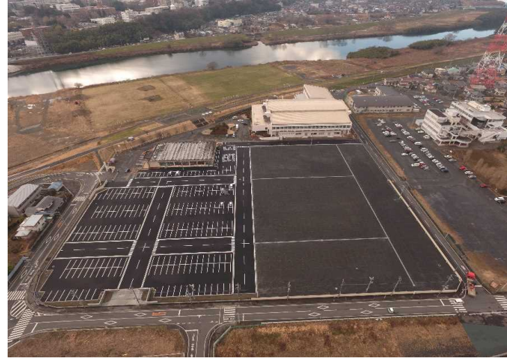
No.2 秋山・海老澤JV 青柳公園駐車場整備工事
