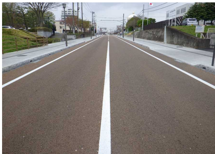
No.19 平和・海老澤JV 都市計画道路3・4・14号道路改良・電線共同溝(4工区)及び公共下水道北見・根本排水区枝線(3-1工区)工事
