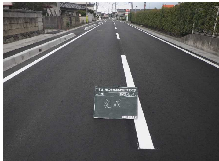
No.23 (有)渡辺鉄鋼建設 寿50号線道路改良(3工区)工事
