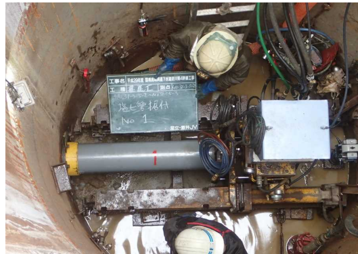
No.4 足立・酒井JV 国補流域関連下水道逆川第4幹線工事
