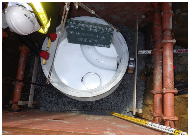
No.7 小河原設備工業(株) 流域関連下水道逆川第1処理分区枝線(2-5工区)工事
