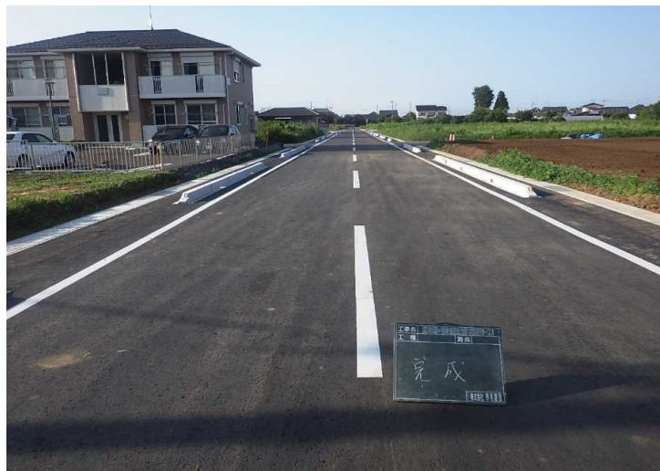
No.5 (株)市毛建設 28東第3号都市計画道路7・6・1号東前原線外2路線道路改良 及び流域関連下水道常澄第2処理分区枝線(4-5工区)工事
