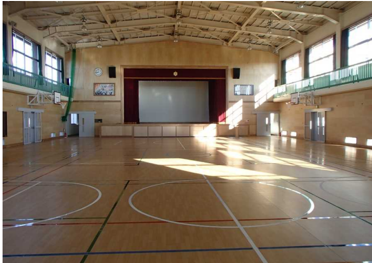
No.1 葵・瀬谷JV 水戸市立浜田小学校屋内運動場長寿命化改良工事
