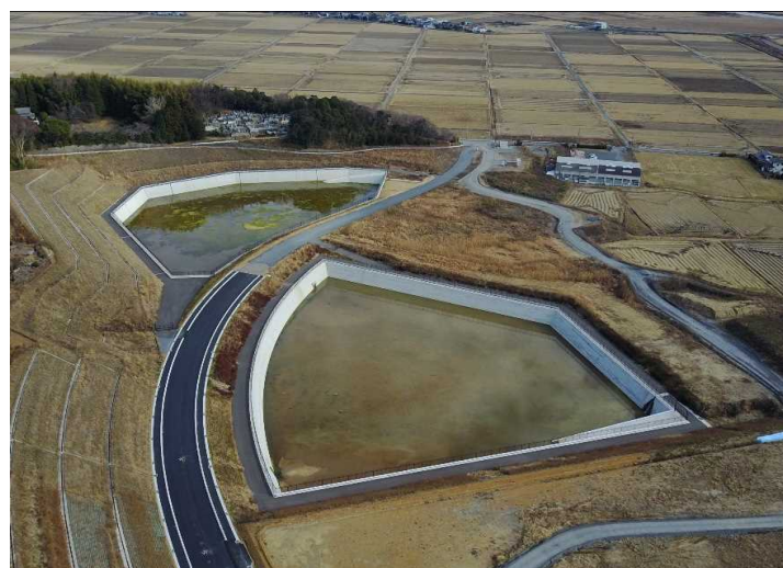
No.20 横田・足立・市毛JV 新ごみ処理施設用地造成(第1工区)工事
