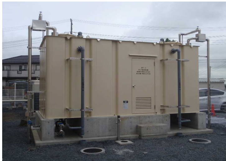
No.15 高橋商事(株) 水戸市立下大野小学校長寿命化改良機械設備 (給排水)工事
