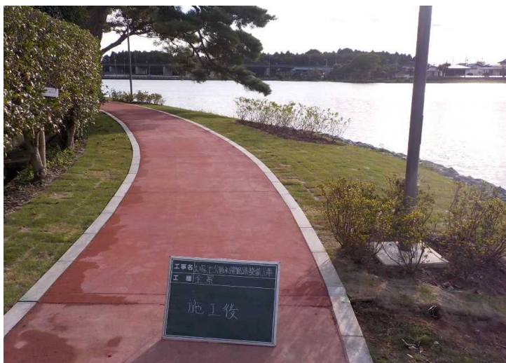
No.11 興和緑地建設(株) 大塚池公園水際園路整備工事
