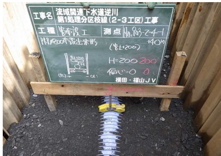
No.21 横田・福山JV 流域関連下水道逆川第1処理分区枝線(2-3工区)工事
