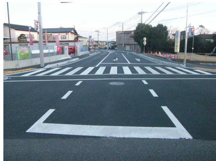
No.22 (株)綿正工務店 河和田・開江線道路改良工事
