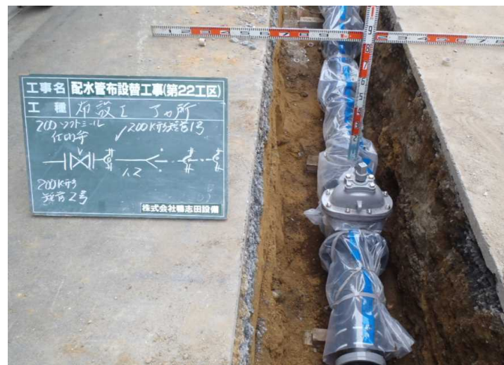
No.8 (株)鴨志田設備 配水管布設替工事(第22工区)
