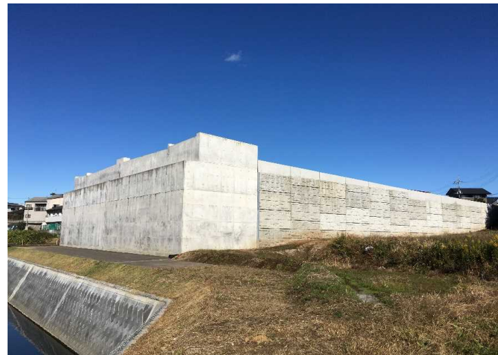
No.16 東洋・上水戸関JV 都市計画道路3・3・2号中大野中河内線(松が丘工区) 道路改築(2工区)工事
