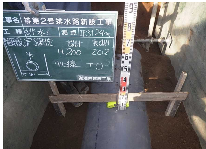
No.12 (有)酒井建設工業 排第2号 排水路新設工事
