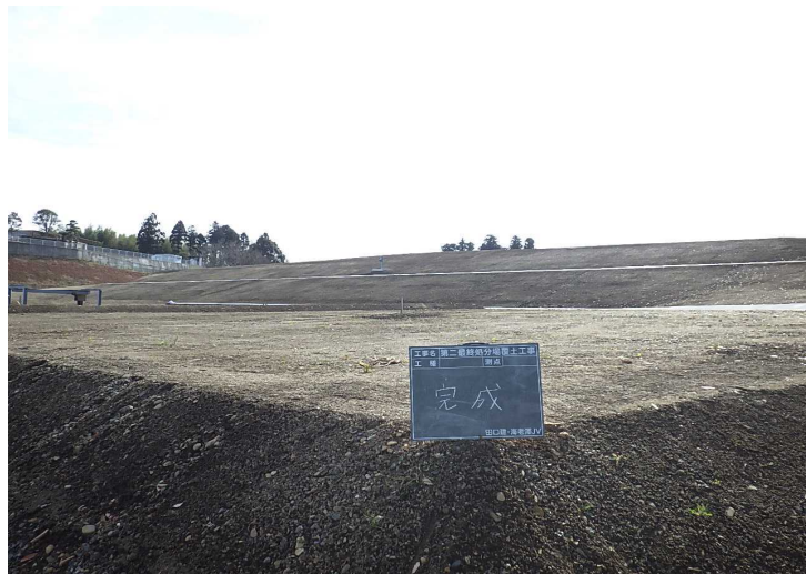
No.17 田口建・海老澤JV 第二最終処分場覆土工事
