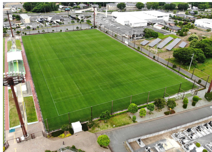
No.28 横田・杉森JV 市立サッカー・ラグビー場天然芝張替工事
