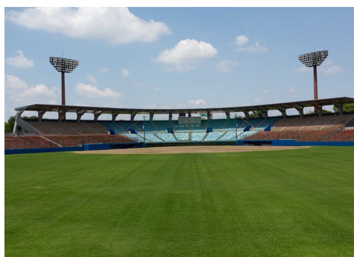
No.12 昭和・水戸土建・五十嵐JV 水戸市総合運動公園市民球場改修工事
