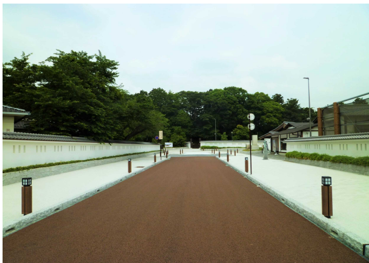
No.23 豊島・トキワ 市道上市205号(353号)線道路改良・電線共同溝工事(5工区)
