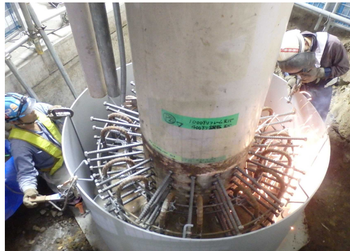
No.14 鈴縫・常磐JV 水戸駅北口駅前広場改修工事(3工区)
