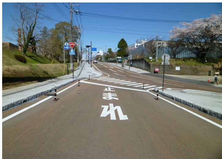
No.3 秋山・シンJV 市道上市6号線道路改良・電線共同溝(1工区)及び 公共下水道北見・根本排水区枝線改築(3-1工区)工事
