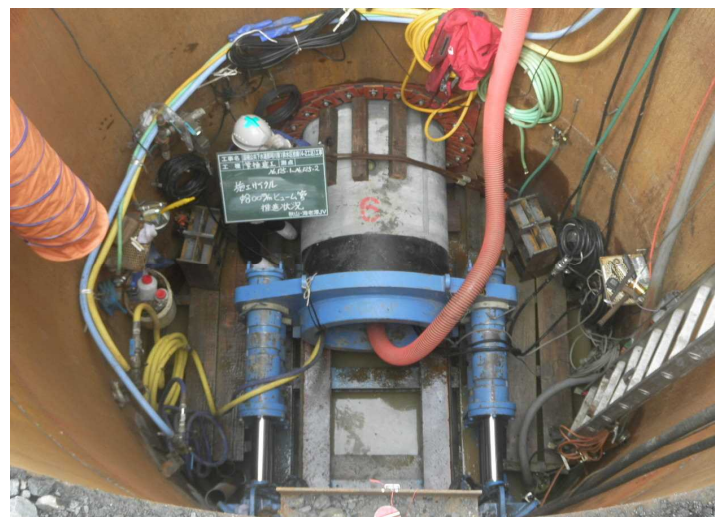
No.2 秋山・海老澤JV 国補公共下水道那珂川第1排水区枝線(4-2工区)工事
