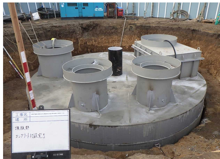
No.4 秋山・綿正JV 耐震型循環式飲料水貯水槽設置 及び配水管布設替工事(第57工区)
