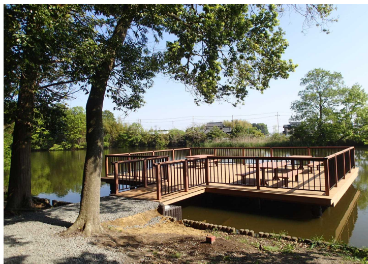
No.7 (株)植幸 宮脇池周辺整備工事
