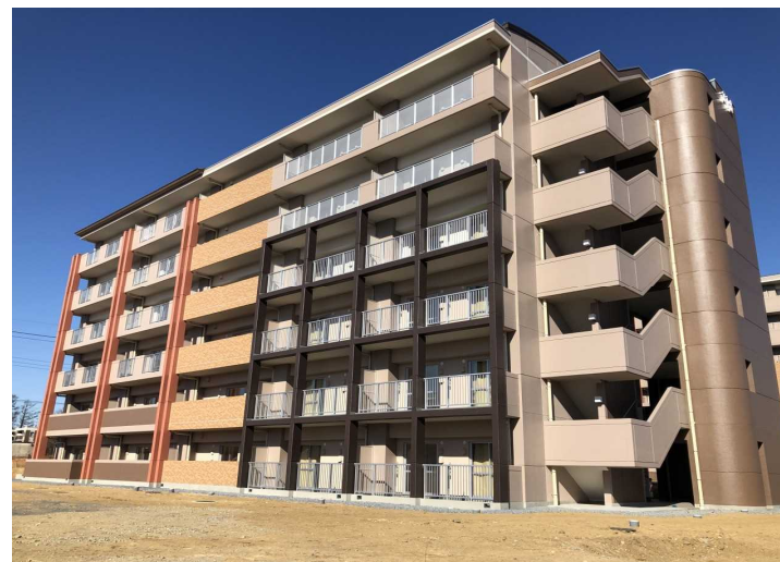
No.24 西山・東・関口JV 河和田住宅新築(第8工区)工事
