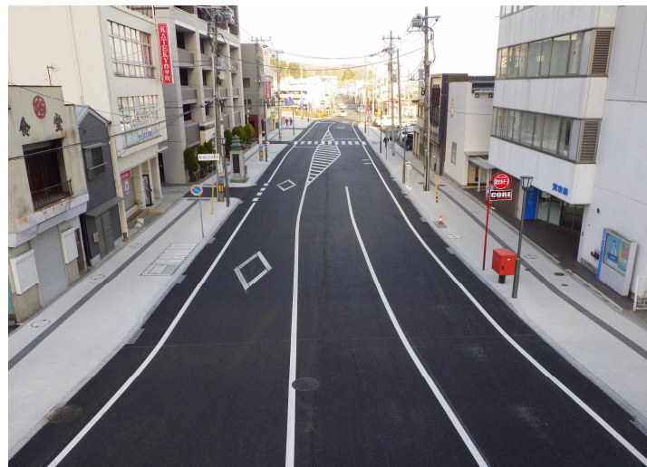
No.26 横田・海老澤JV 幹線市道1号線道路改良・電線共同溝工事
