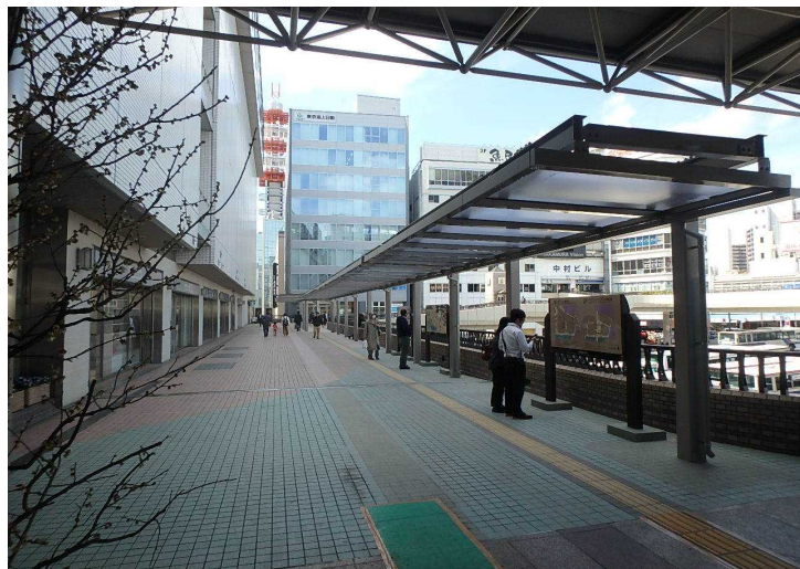
No.9 株木・田口建JV 水戸駅北口駅前広場改修工事(4工区)
