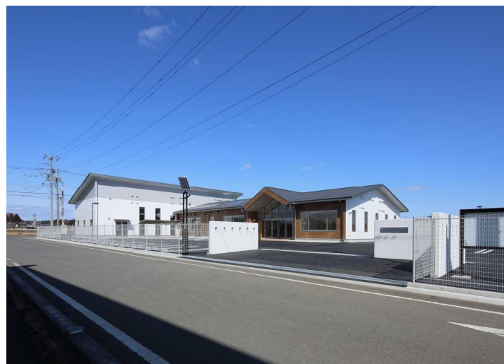
No.10 コスモ・藤和JV 妻里市民センター建設工事
