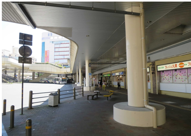
No.5 足立・酒井JV 水戸駅北口駅前広場改修工事(2工区)
