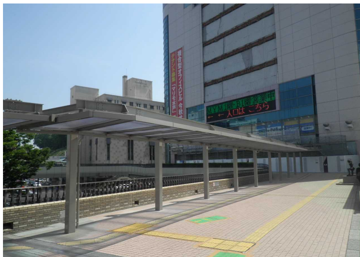
No.27 横田・アルプスJV 水戸駅北口駅前広場改修工事(1工区)
