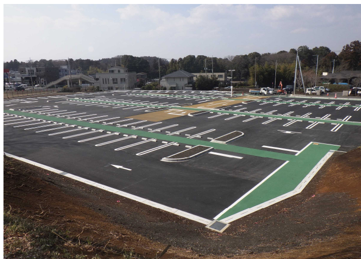
No.19 第一熱学建設(株) 国補千波公園少年の森駐車場整備工事
