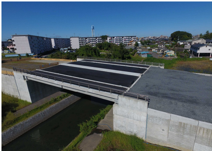
No.21 豊島・常磐JV 都市計画道路3・3・2号中大野中河内線(松が丘工区)橋梁 上部工工事
