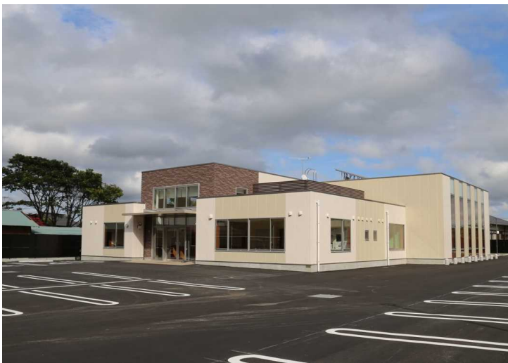
No.15 関根・昭和鐵工JV 鯉淵市民センター建設工事
