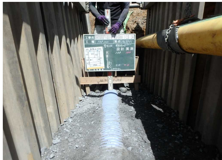
No.6 (株)市毛建設 国補流域関連下水道逆川第1処理分区枝線(2-3工区)工事
