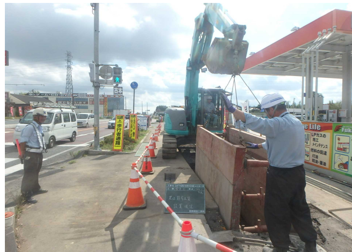
No.16 高橋建設工業(株) 国補公共下水道桜川処理分区枝線(4-3工区)工事
