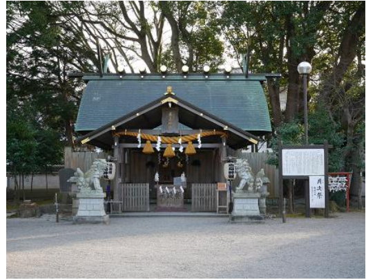
市指定文化財 鹿島神社本殿・拝殿・中門及び瑞垣 みずがき (2017（平成29）年2月指定)
