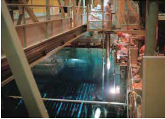
使用済燃料貯蔵プールでの燃料移動作業（原電）
