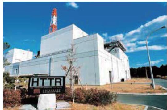
高温工学試験研究炉（HTTR）（機構大洗）
