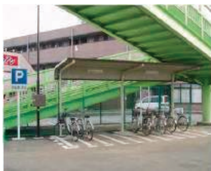
図9 路上駐輪場の設置事例
