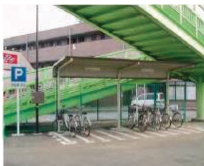
図9 路上駐輪場の設置事例
