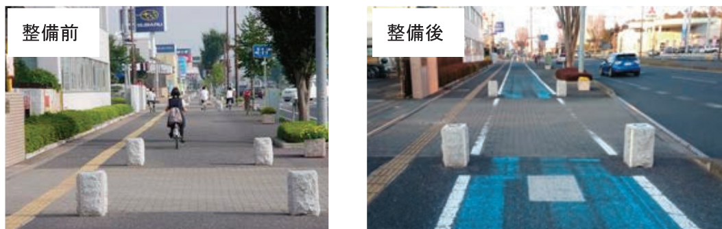
図 1-28 主要地方道水戸神栖線の整備前、整備後の状況
