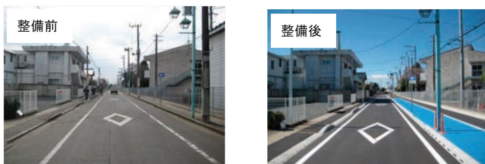
図1-30 幹線市道4号線の整備前，整備後の状況
