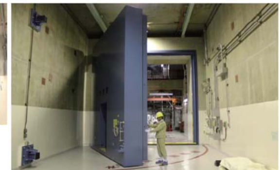
原子炉建屋大物搬入口 水密扉 （開放状態）
