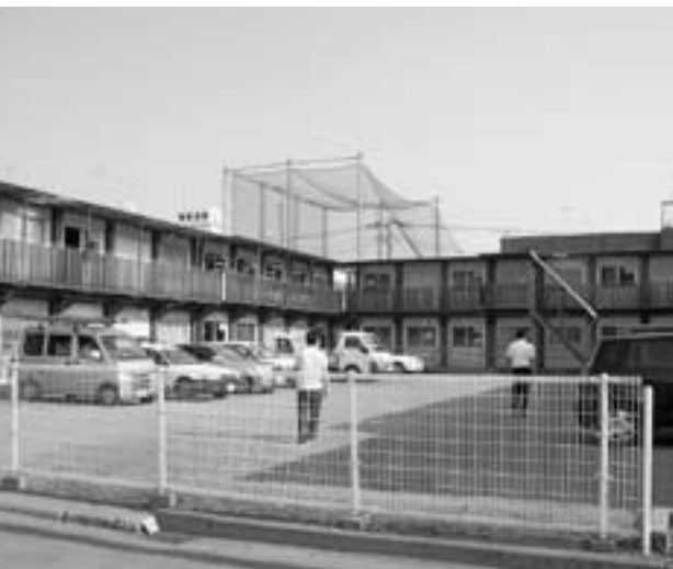
震災の影響で市役所本庁舎が使用不可能となったため、新たに建設された市役所市民会館東側臨時庁舎
