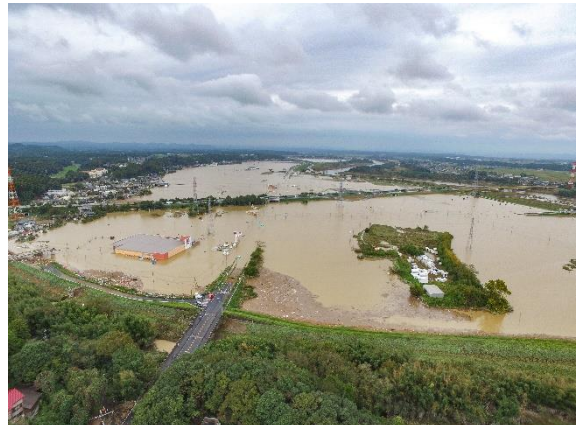
令和元年台風第19号の被害（飯富地区）
