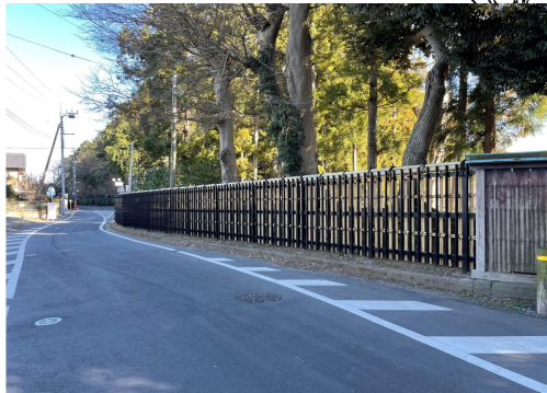
① 板塀整備工事
