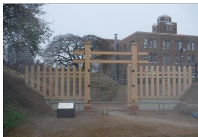
北柵御門復元整備(完了後)
