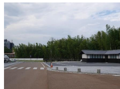
弘道館東側用地整備事業 (R1)
