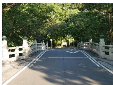
大手門復元整備（着工前）
