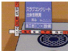
⑯上部スラブコンクリート 厚み確認 H=〇〇
